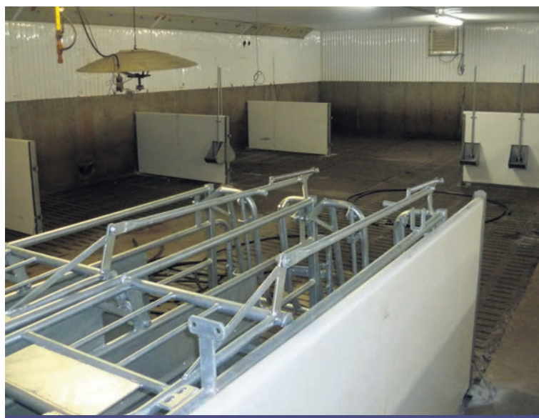
Aménagement du parc permettant de loger 40 truies : on a utilisé sans les modifier les planchers d'engraissement et on s'est servi des divisions de plastique et des poteaux de l'engraissement pour faire les couchettes.
